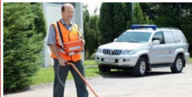
Im Zuge der routinemäßigen Wartung des Gasnetzes wird die Leitungstrasse mit einem Gasspürgerät abgegangen und auf Funktionstüchtigkeit geprüft.
